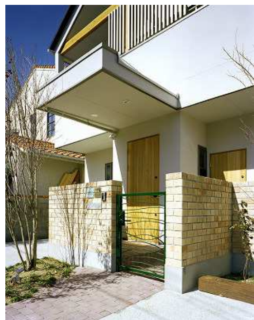
ロートアイアン門扉とレッドオーク玄関扉
