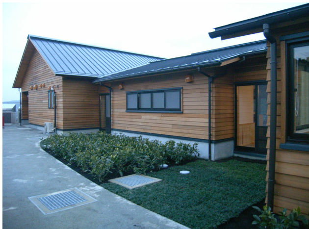
■ 北側通路/奥:厨房入口 中:3・4・5オトイレ
