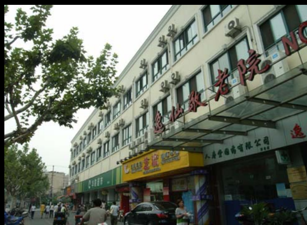
市内の養老施設(浴場施設を改造)
