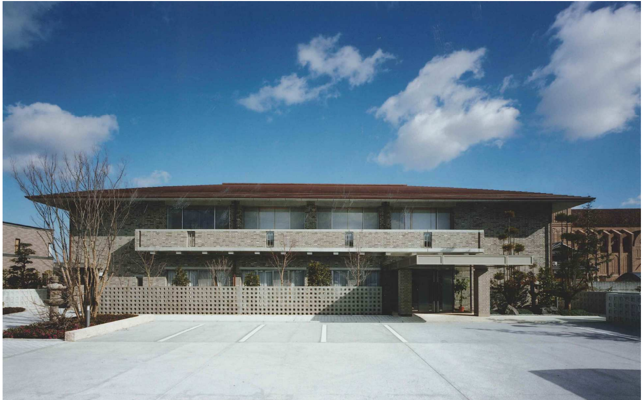
前面道路より全景
