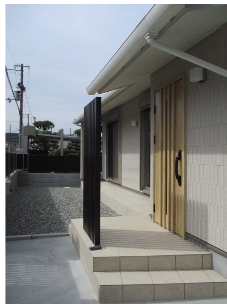
目隠しルーバーを取付けたポーチ
